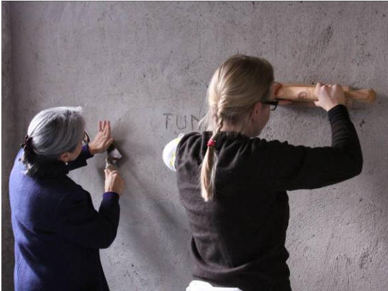
Abb. 17 Gruppe 3. Verdichten der Unterputze
