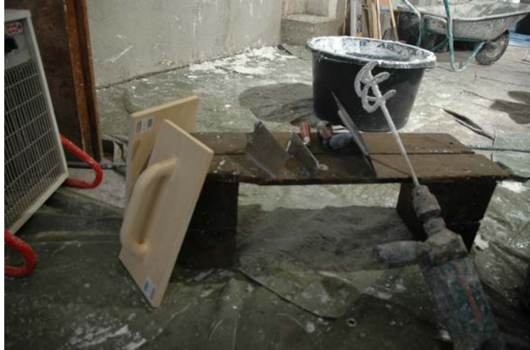
Abb. 3 Werkzeuge zur Mörtelbereitung, Verputzen und Glätten
