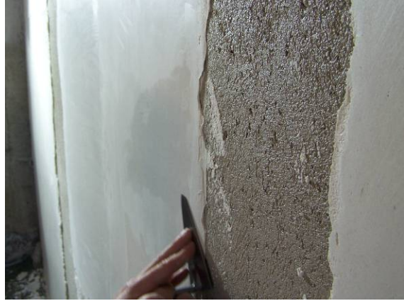
Abb. 10 Gruppe 1. Glattziehen des 1. Oberputzes
