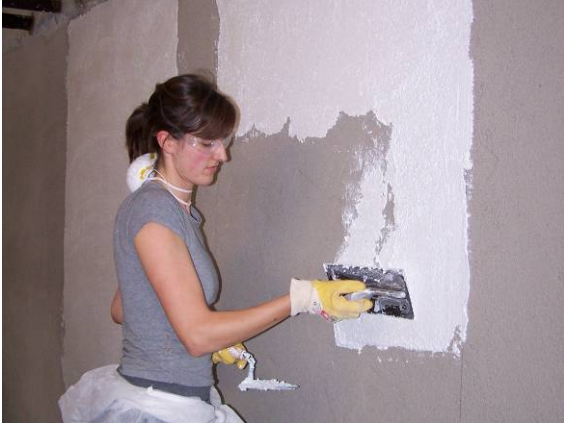
Abb. 9 Gruppe 1. Auftragen des 1. Oberputzes
