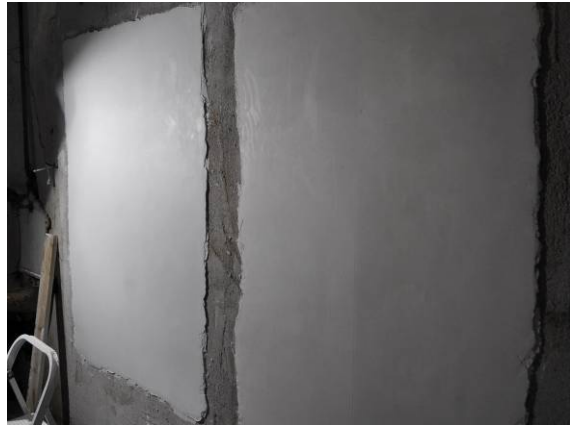
Abb. 14 Gruppe 2. Nach Auftrag des 2. Oberputzes
