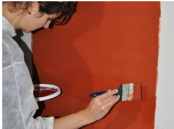
Abb. 16 Gruppe 2. 3. o. 4. lasierender Farbauftrag
