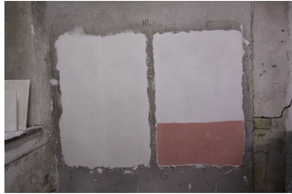
Abb. 39 Wandfelder der Gruppe 3. Zwischenzustand nach Auftrag der Feinschicht.
