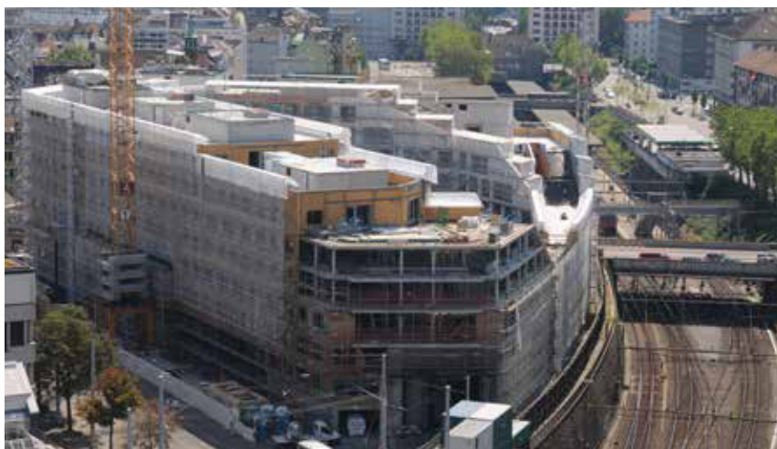
Baustelle Kalkbreite: Eine der Herausforderungen war die innerstädtische Lage zwischen Eisenbahn, Tram und zwei stark frequentierten Strassen in Zürich-Wiedikon.
