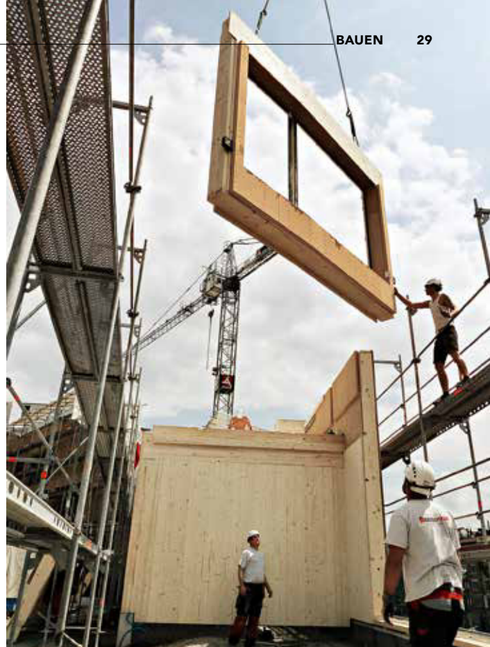
Die Anlieferung für die Montage der Holzelemente für die Aussenwand musste just in time erfolgen.
