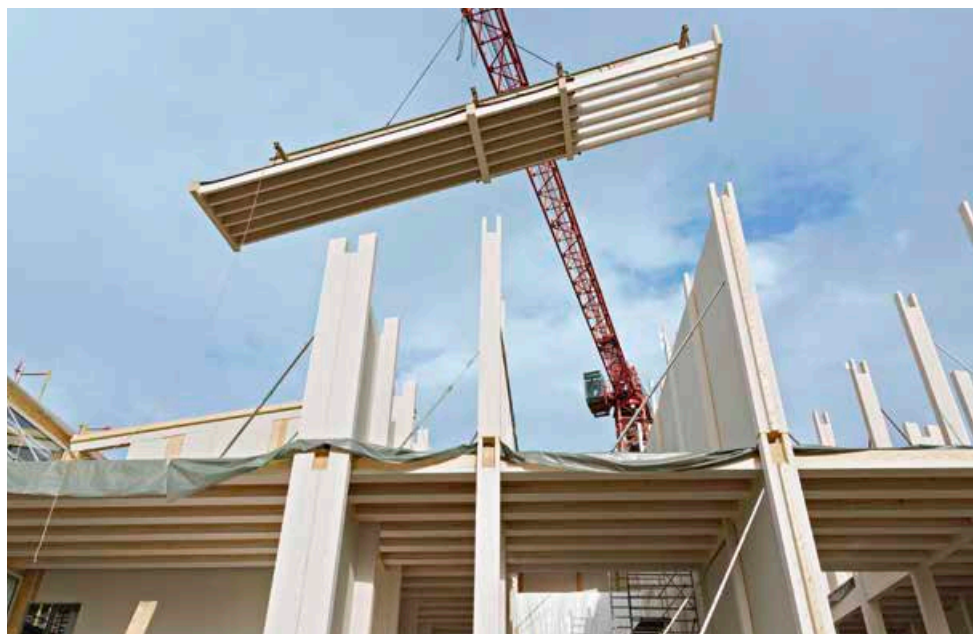
► Baufortschritt: Montage der Schrägdachelemente
