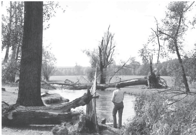
Sturmschäden 1963 am Schwabinger Bach mit Haus der Kunst im Hintergrund
