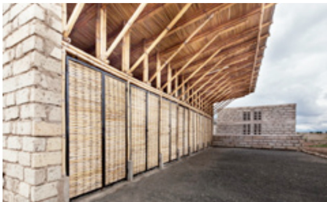
2012 fertig gestellte Handwerksschule in Kenia
