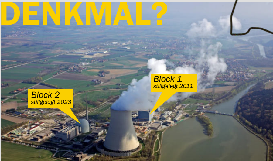
2 Kernkraftwerk Isar Bildquelle: https://www.sueddeutsche.de/bayern/bayern-isar-2-leck-atomkraftwerk-gruene-1.5662653
