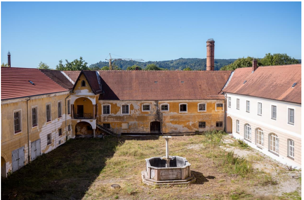
Blick in den zweiten Innenhof – vom „Hochschloss“
